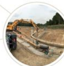
DÉVIATION DE CANALISATION
