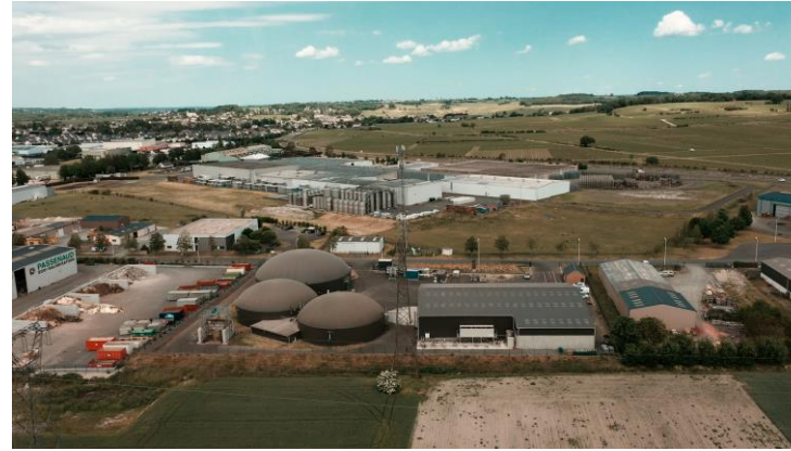
Lucien GERBIER à SAUMUR Méthaniseur raccordé au réseau
