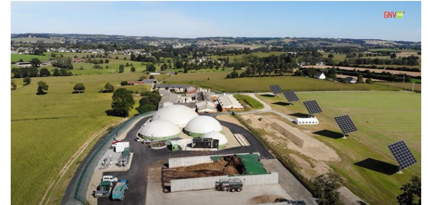
Frères MOREL à FOUGERES Méthaniseur raccordé au réseau
